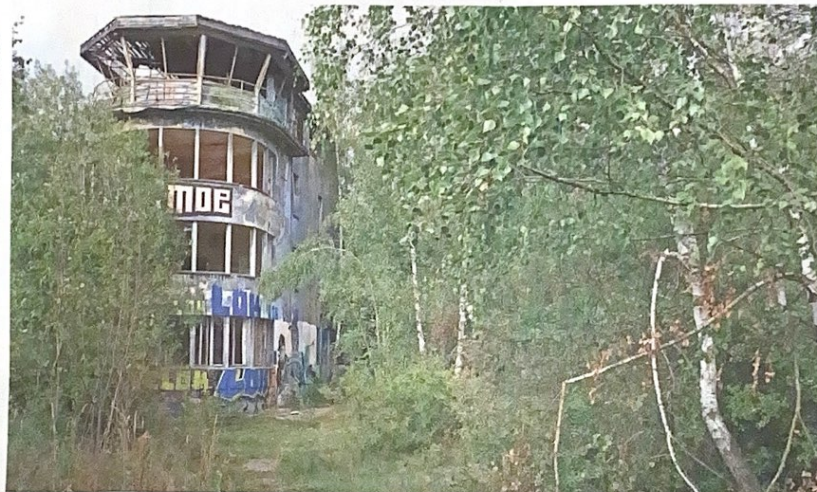
Der verlassene Tower ist eingewachsen: In den über 30 Jahren seit der Übergabe des einstigen Militärflugplatzes Waldpolenz an die Stadt Brandis hat sich die Natur das Areal zurückerobert. Die Firma Juwi will hier bis zu fünf Windräder errichten. FOTO: THOMAS RUBE
